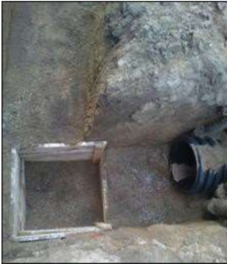
Fosos decantadores a la entrada de una alcantarilla
