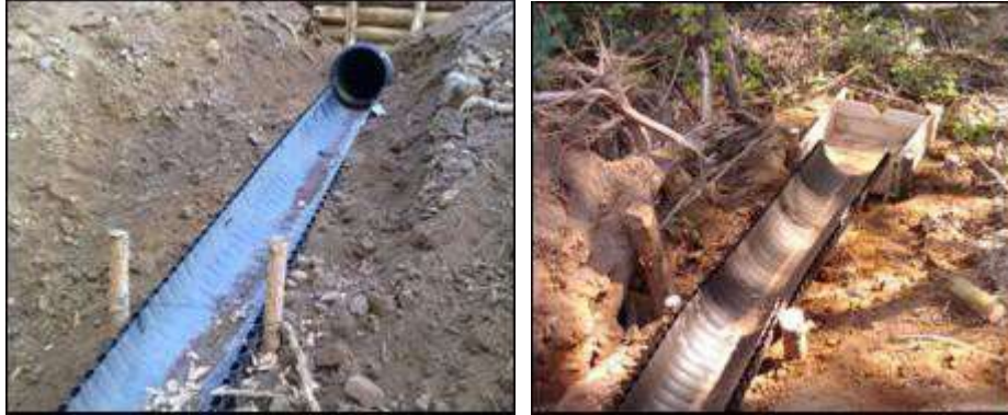
Bajadas de Agua post alcantarillas
