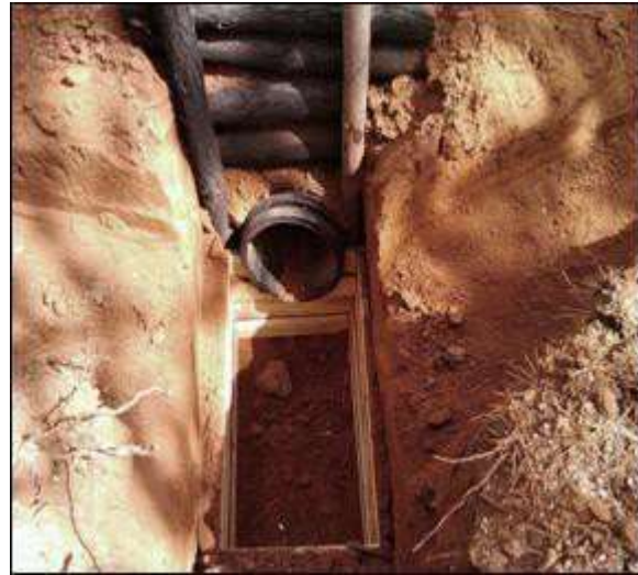
Fosos decantadores a la entrada de una alcantarilla
