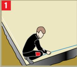
**1** Trazar la ubicación del muro en el piso. Medir la longitud.
