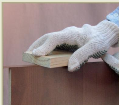
Pegar el tapacantos partiendo desde un extremo y a medida que vaya pegando, debe ir presionando fuertemente con un rodillo o con un trozo de madera de manera uniforme, para asegurar la correcta adherencia y evitar que quede soplado.
