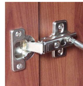
• **Entre los laterales:** Ajustar la posición apretando o soltando el tornillo que se indica. Es muy útil en el caso de muebles con varias puertas, para tener una separación pareja entre ellas.
