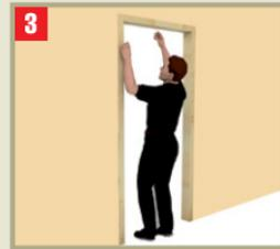
**3** Verificar los plomos usando plomada o nivel, primero en el lado de las bisagras y luego en el lado de la cerradura. Para ajustar el marco al muro, usar cuñas de madera.
