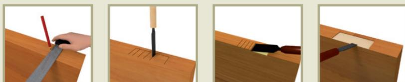
Marcar la posición de las bisagras en la puerta, hacer el rebaje. Es importante que las bisagras queden aplomadas. La profundidad del rebaje debe ser igual al espesor del cuerpo de la bisagra.
