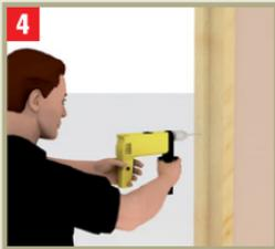
**4** El marco se fija a la estructura de madera usando tornillos o tornillos y tarugos en caso que sea de albañilería.
