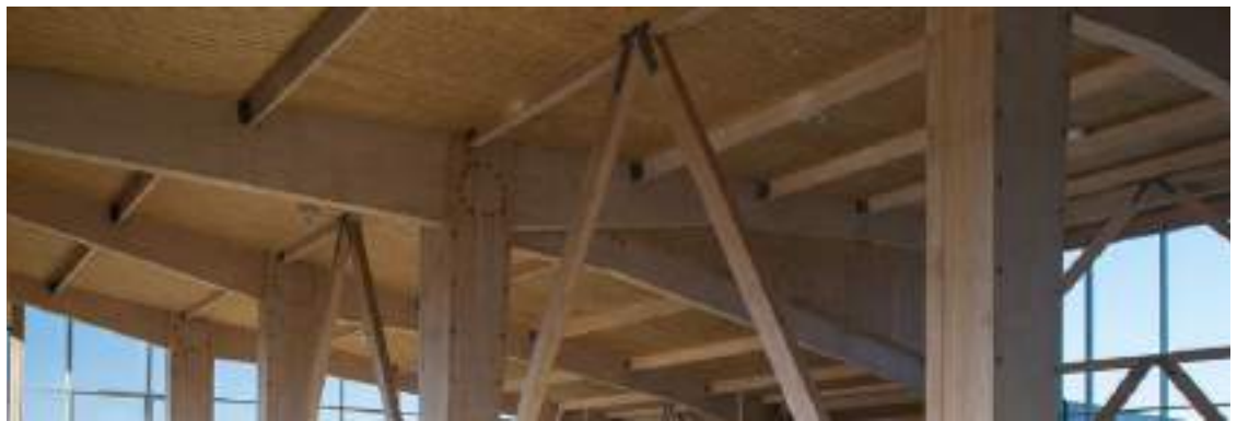
Figura 4: Uniones semirrígidas con disposición de sujesores en círculo.
