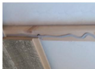
**Detalle:** Dejar una separación de 10 mm en todos los costados que van al piso, cielo y paredes, como se indica en los detalles.
