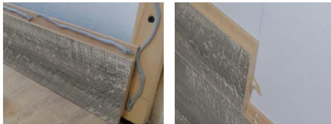
**Detalle:** Dejar una separación de 10 mm en todos los costados que van al piso, cielo y paredes, como se indica en los detalles.
