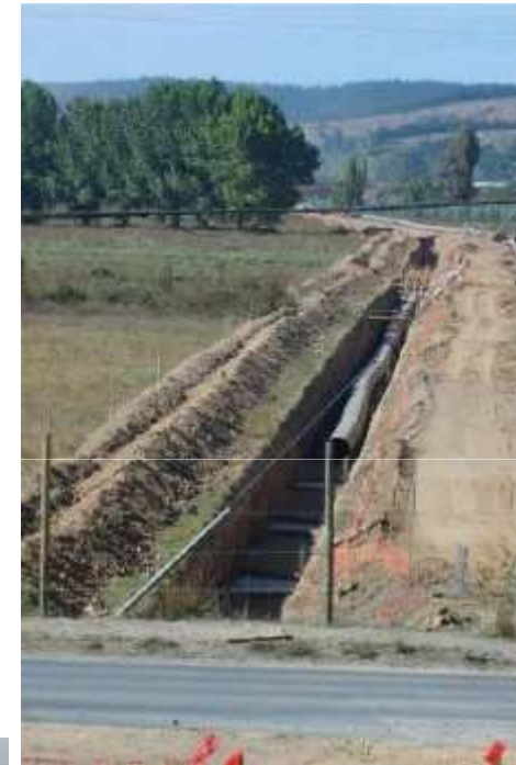
↑ Construction of Nueva Aldea pipe
